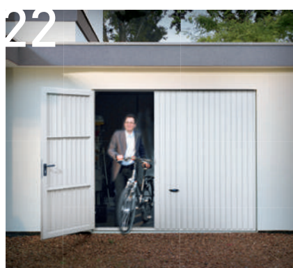
Schlupftüren und Nebentüren
